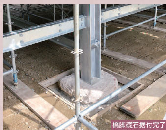
橋脚礎石据付完了
