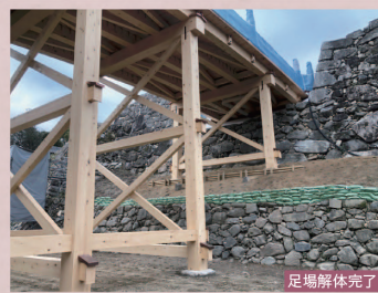
足場解体完了
